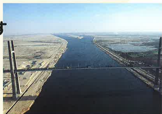
内陸部やスエズ運河(写真)沿いに位置する経済特区により、新たなビジネスチャンスが期待される
